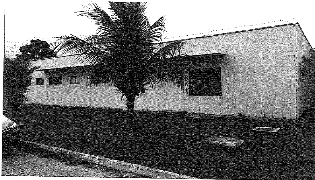
Imagem 01: fachada lateral da edificação
